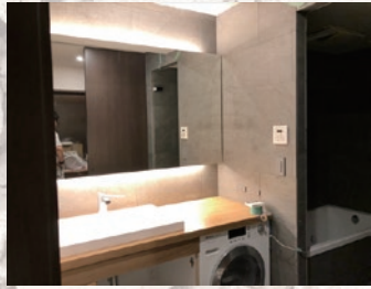
③J様邸 ユーティリティ (工事途中写真)
